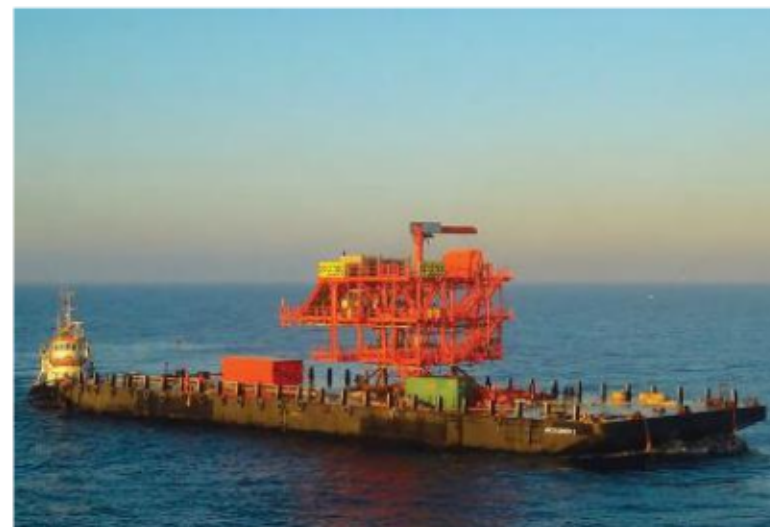
Il cantiere in mare per la realizzazione del rigassificatore
